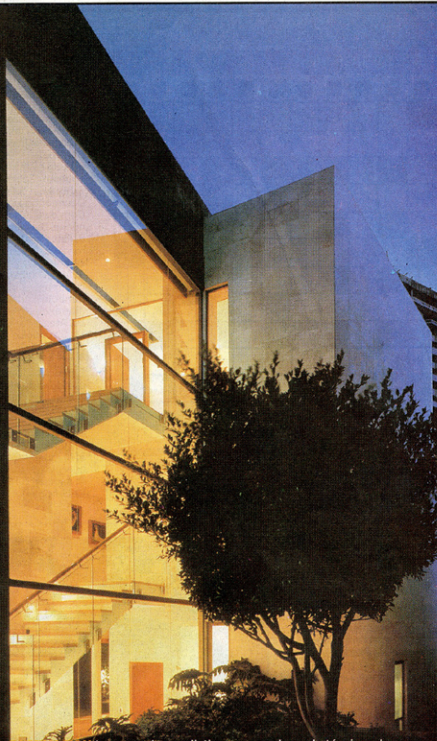
ILUMINACIÓN Los espacios se distinguen por el uso de técnicas de iluminación, como el baño de muro.
