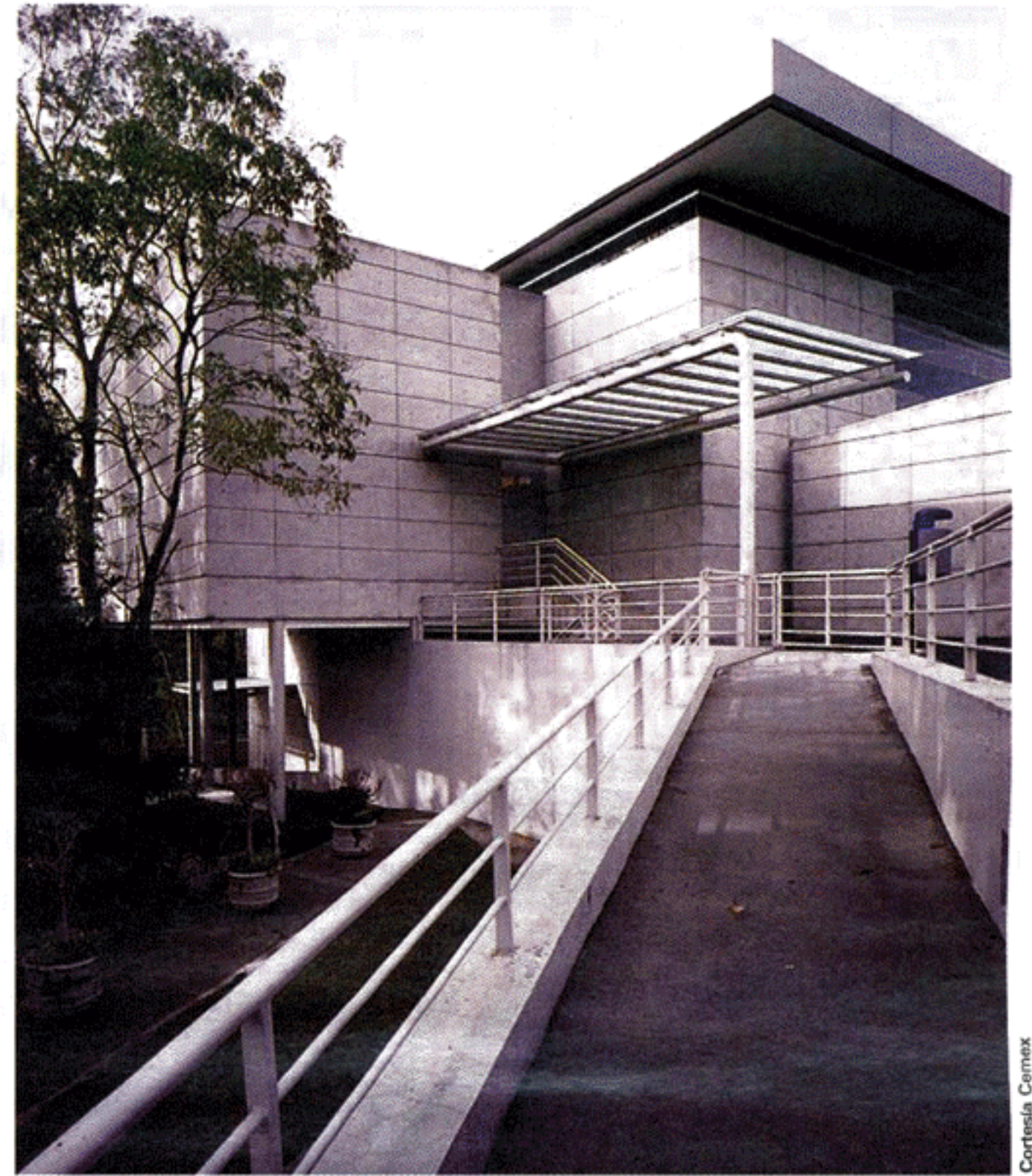
> En el salón de usos múltiples Tarbut destaca la modulación lineal de las fachadas de concreto.
