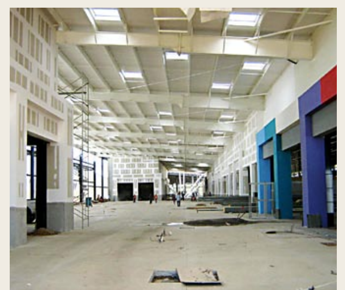
El avance de obra es notable.
